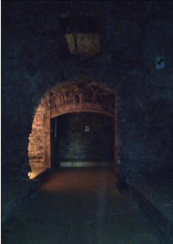
**Abb. 12:** Kellergewölbe des stark verzweigten Bierkellers, sichtbar sind die unverputzten Natursteinwände. [Bildquelle: © Martina Tospann]
