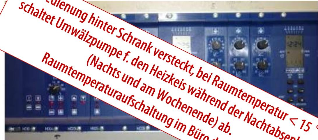
**Fernbedienung hinter Schrank versteckt, bei Raumtemperatur  $< 15^\circ$  schaltet Umwälzpumpe f. den Heizkreis während der Nachtabsenkung (Nachts und am Wochenende) ab.
