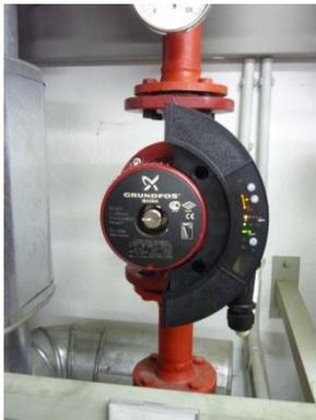
Die Umwälzpumpen waren trotz Außentemperaturen von weit über 20° C in Betrieb, wie auch die Boilerladepumpe, obwohl eine Solaranlage installiert ist und die Speicher schon Temperaturen von über 60° C erreicht hatten.
