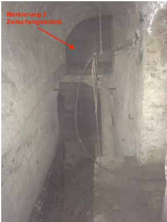
Zugang Zwischengeschloß, Markierung 2
