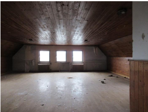
Dachgeschoss mit Holzverkleidung (Südseite)
