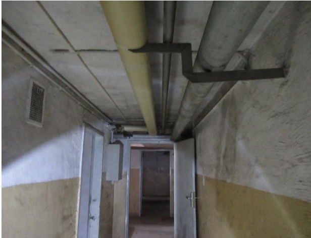
Keller mit glatt verputzten Wänden und ohne Quartierpotenzial
