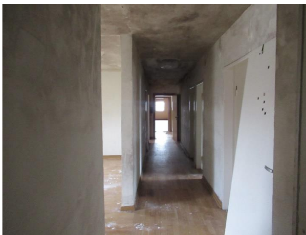
Obergeschoss mit glatt verputzten Wänden und ohne Quartierpotenzial
