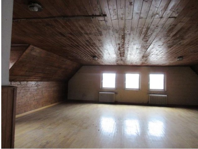
Dachgeschoss mit Holzverkleidung (Südseite)
