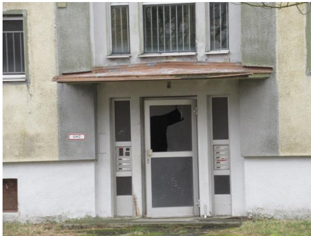
Eingeschlagene Türe im Erdgeschoss mit potenzieller Einflugmöglichkeit für Tiere
