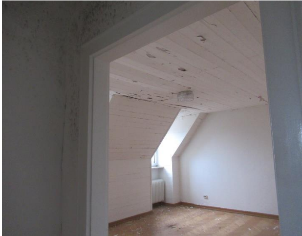
Dachgeschoss mit glatt verputzten Wänden und ohne Quartierpotenzial
