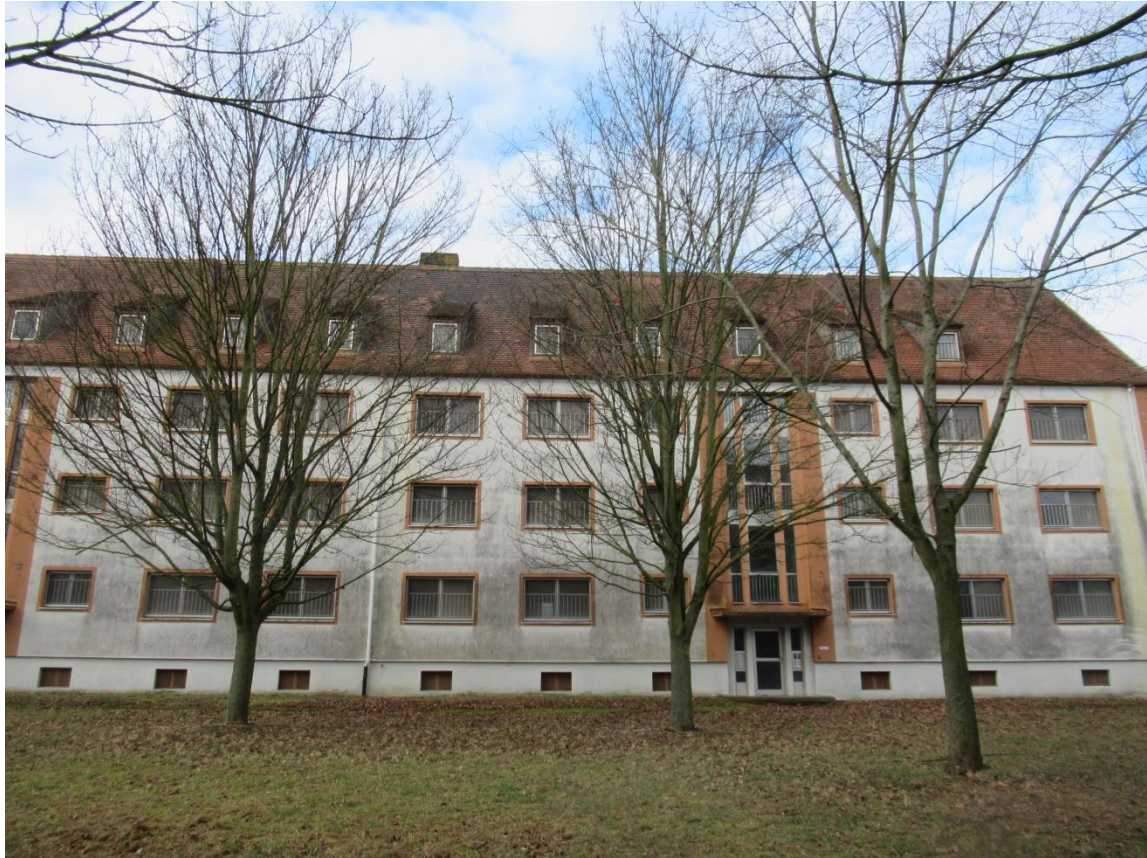
Abbildung 2: Eines der beiden von Abriss betroffenen Gebäude (301). Foto: A. Hilbert, 31.01.2024.
