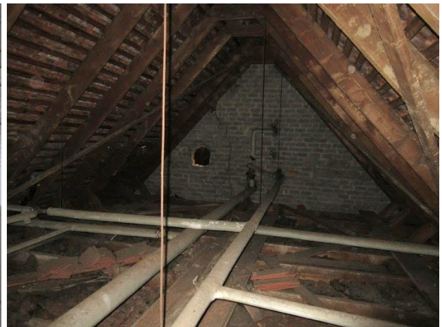
Teil des Spitzbodens durch Mauerwerk abgetrennt
