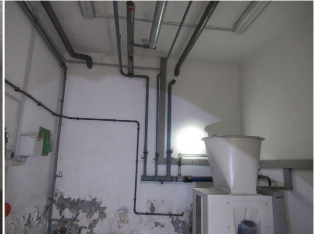
Heizkeller mit glatt verputzten Wänden und ohne Quartierpotenzial
