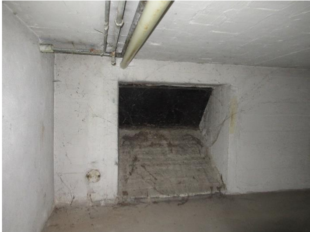
Kohlekeller mit glatt verputzten Wänden und ohne Quartierpotenzial
