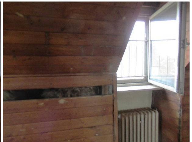
Einflugmöglichkeit in Form von offenem Fenster sowie fehlendes Stück in Holzverkleidung
