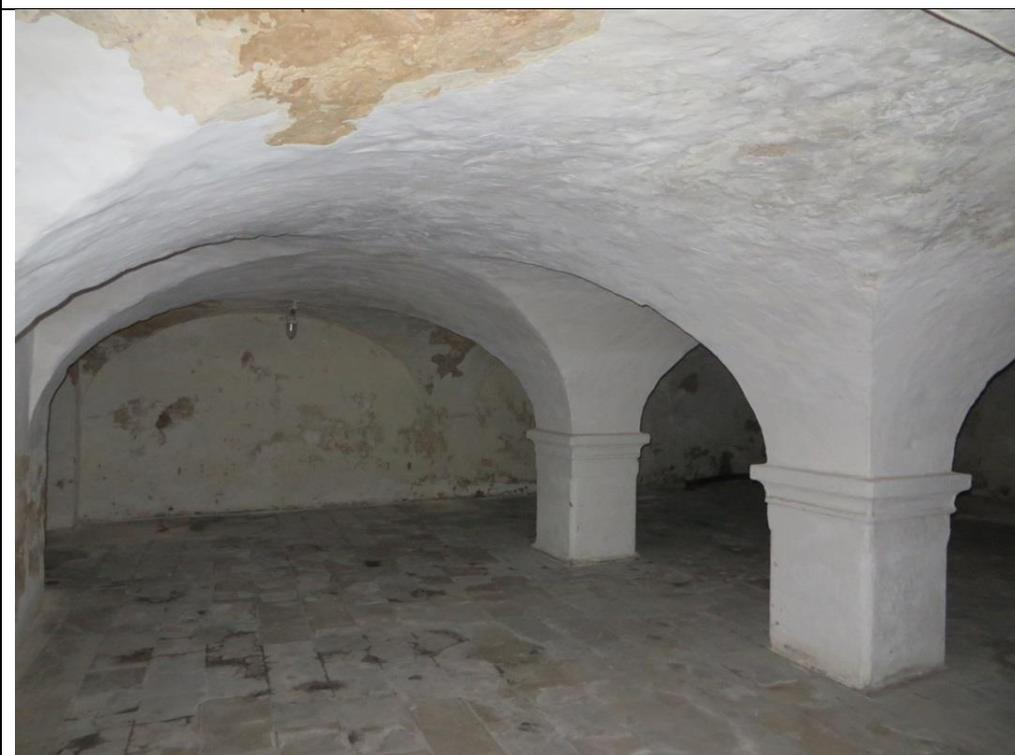
**2. Kellergeschoss, betonierte Kreuzgewölbe**
