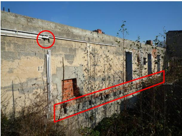
**Foto Nr. 15:** Jeweils die Nord- und Südwand der ehemaligen Sägewerksruine bestand aus Hohlblocksteinmauern. In den Hohlblocksteinen befanden sich durch ausgebrochene Befestigungen viele Löcher (s. rote Markierungen) und damit potenzielle Eingänge für Tiere zu dahinterliegenden Hohlräumen. Foto: Ullrich, 22.11.11
